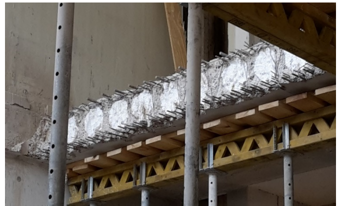
Bild 6 Vorhandene Decke mit Styroporröhren
