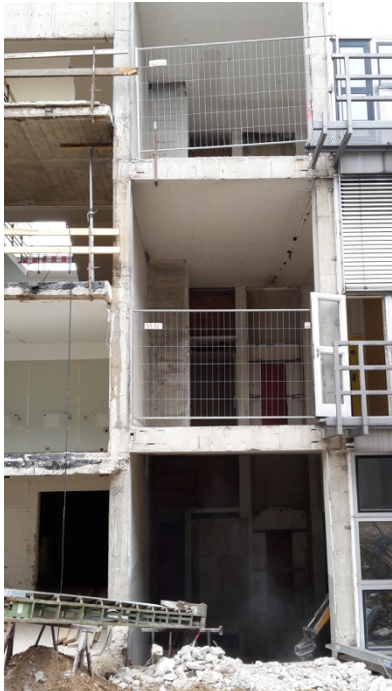
Bild 2 Hier entsteht der neue Aufzug
