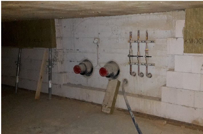
Bild 6 Anschluss Kälte und Gase im Kriechkeller
